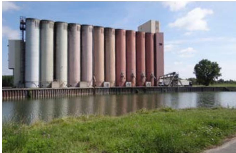
Silos de Bucy-le-Long depuis Vénizel, illustration de l'Aisne industrielle
