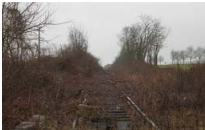
Enfrichement de la ligne Rochy Condé
